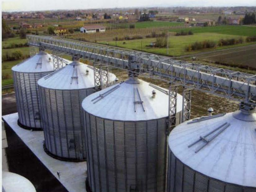
I nostri silos in lamiera sono particolarmente adatti per lo stoccaggio di prodotti granulari quali cereali con peso specifico pari a 840 kg./dmc. Il calcolo viene eseguito seguendo la formula di Jansen in conformità agli standard americani A.I.S.C. ed A.S.B.C. dove risultano normalmente soddisfatte le norme DIN 1055. I carichi accidentali considerati sono: la pressione del vento generata a 170 km/ora, il carico della neve pari a 90kg/mq. e la forza sismica nulla.
